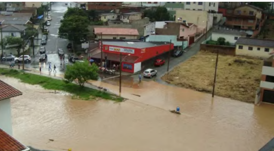
Imagem 12. Alagamento na Avenida Irradiação por uma enchente em 2014. “Chuva provoca estragos em Poços de Caldas e Pouso Alegre, MG”, G1, 2014.
